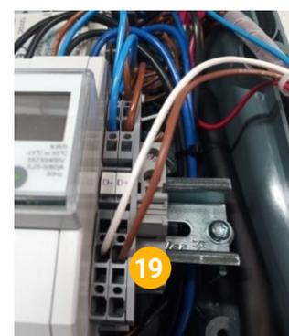
20. Den braunen Draht mit der Beschriftung „12V +“ an der Abgangsseite des Netzteils anheben und mittels beiliegendem Abzweigverbinder mit dem roten Draht des Anschlusssets verbinden
