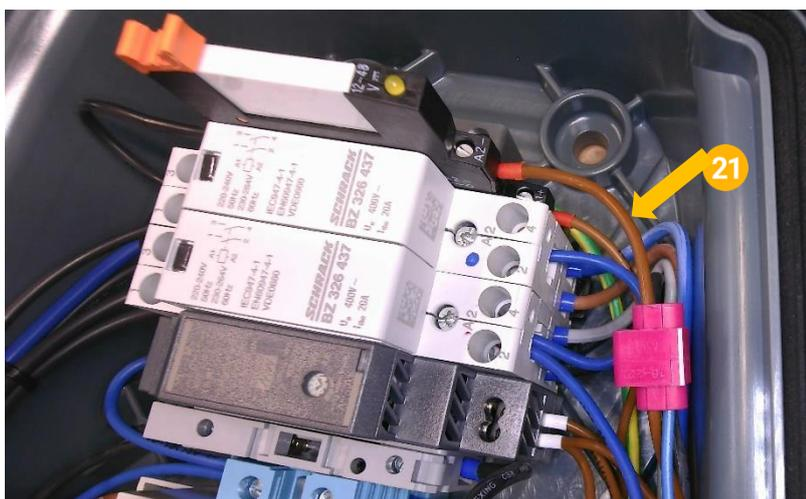
22. Die 12VDC Spannungsversorgung für die RFID-Platine ist installiert
